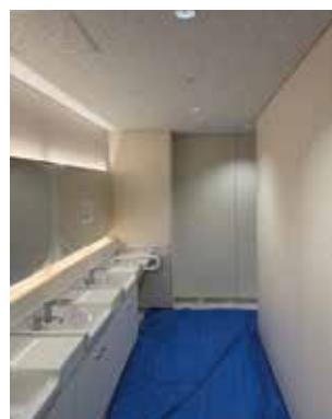
【写真4】 更新工事が進む1階来客用トイレ（2026年5月撮影）
