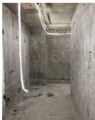
【写真3】 解体後の1階来客用トイレ（2026年1月撮影）
