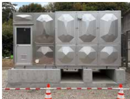
【写真2】 空調室外機置場の西側、来客用駐車場として使われていた場所に新設された受水槽（右側）とポンプ室（2026年5月撮影）
