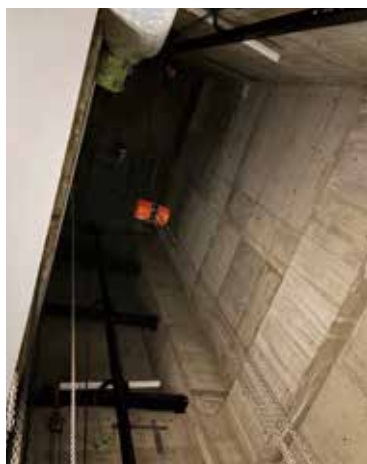
【写真1】 かねて解体後のエレベーターシャフト内（2026年5月撮影）
