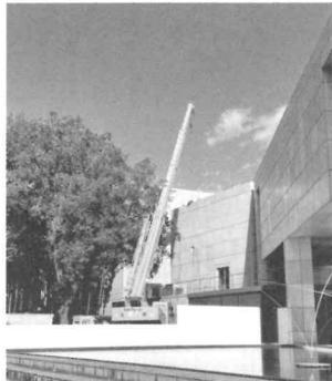
〔写真1〕移動式クレーンで建物上部にある空調機械室へ機器等を搬出入する作業 (2022年1月31日撮影)
