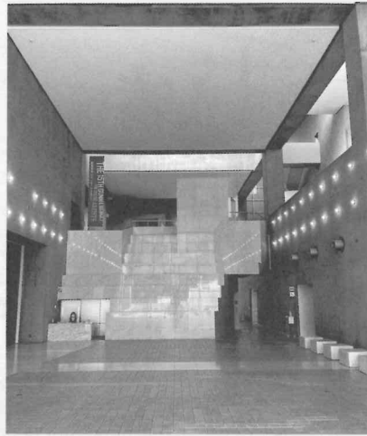
工事対象となるホールの天井
